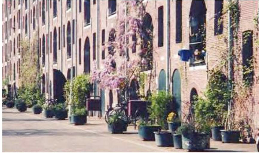
De simples éléments décoratifs sont ici utilisés pour définir la limite entre les espaces publics et les espaces semi-publics © IAU île-de-France
