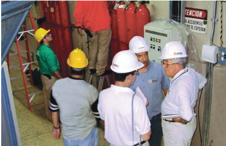
Ingenieros de Protección Contra Incendio evaluando el riesgo de una planta industrial
