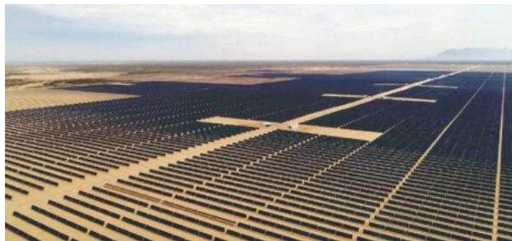
Parque Solar Fotovoltaico Villanueva, de ENEL, en Viesca, Coahuila, México
