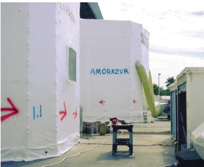
A indústria naval cria invólucros com andaimes e uma membrana especial de plástico retrátil. Sistemas móveis filtram e extraem os vapores da pulverização.
